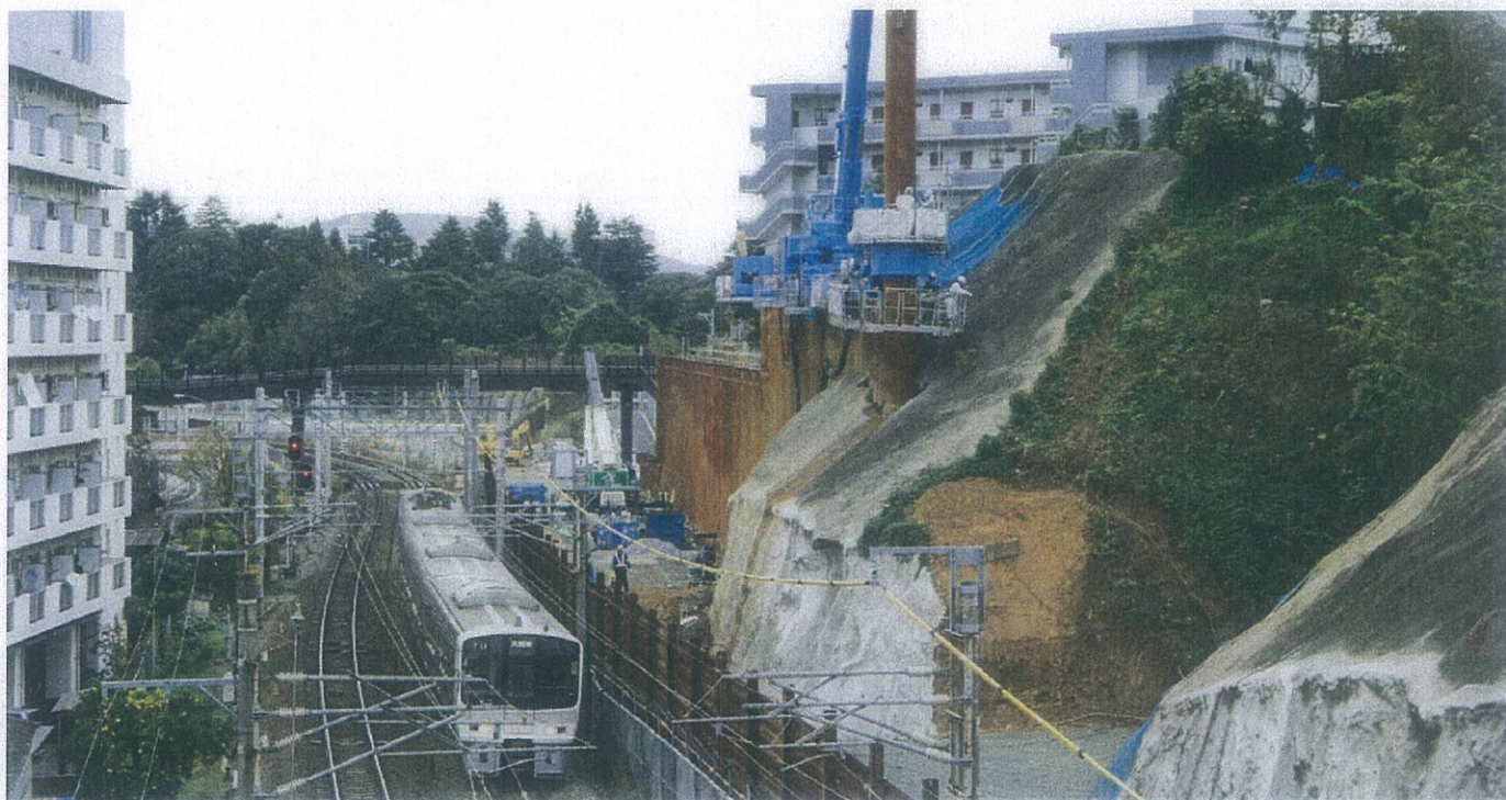
営業線近接施工
